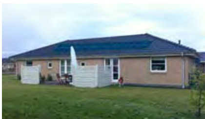
Eksempel solceller lagt på tagfladen.
